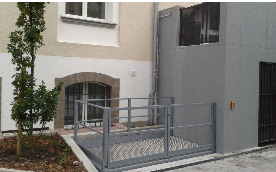
Zweiseitiges Geländer und Tür mit elektro-mechanischer Verriegelung
