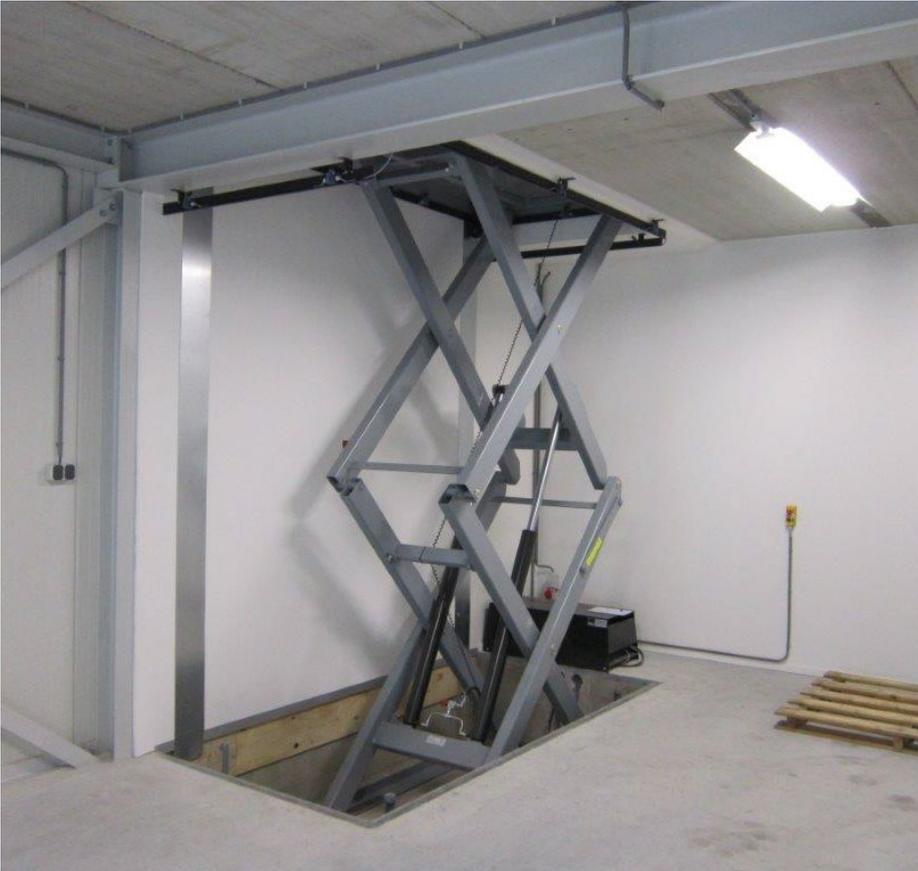
Einbausituation in Grube / durch Deckendurchbruch, Aggregat außenliegend
