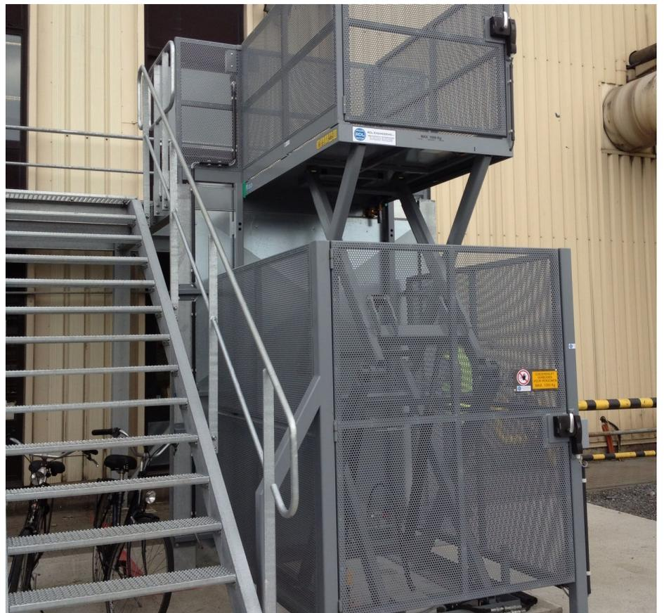
Einbau mit Schutzeinhausung, Geländern und elektro-mechanischer Türverriegelung
