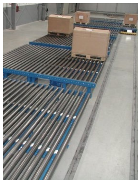
Rangierbahnhof mit Rollenförderern
